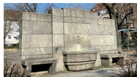
Neuer Trinkwasserbrunnen am Wagnerplatz in Grombühl.
