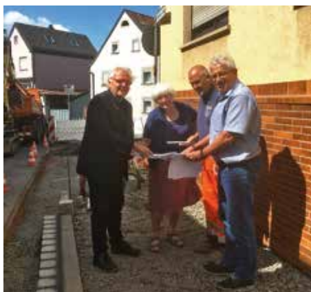
Tiefbau Brunnenstr.: v.l.n.r. Straßenmeister Nürnberger, Stadtrat Hofmann, Stadträtin Hoepffner
